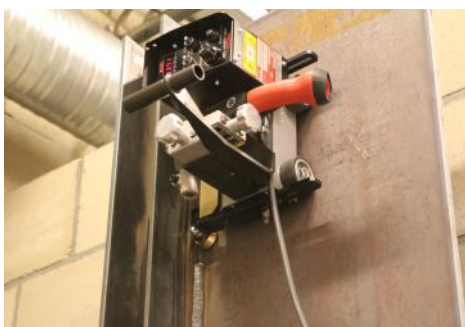
Вертикальная сварка желоба
